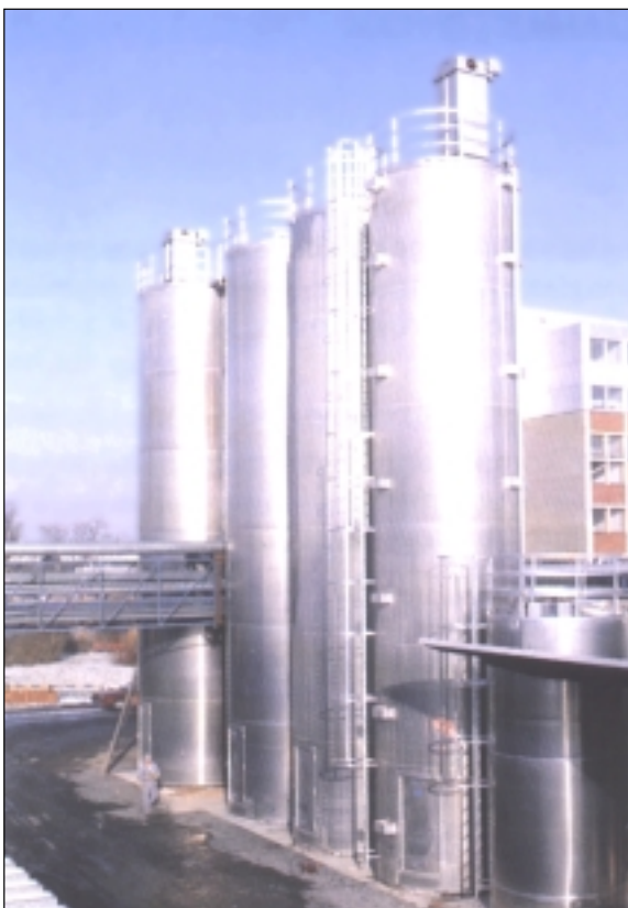
Silosy nowej linii produkcyjnej wysokojakościowych farb gazetowych
